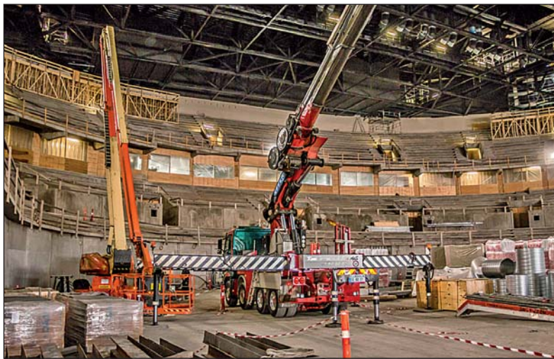
Det er store forhold, der gør sig gældende i den nye multiarena. Det samlede areal er på intet mindre end 35.000 kvadratmeter, så det er intet problem at køre to kæpekraner ind på gulvet.
